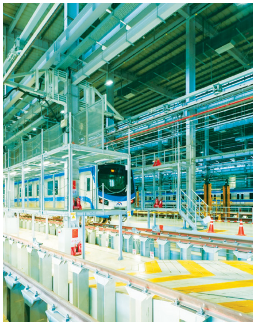
Tuyến Metro số 1 Bến Thành – Suối Tiên
