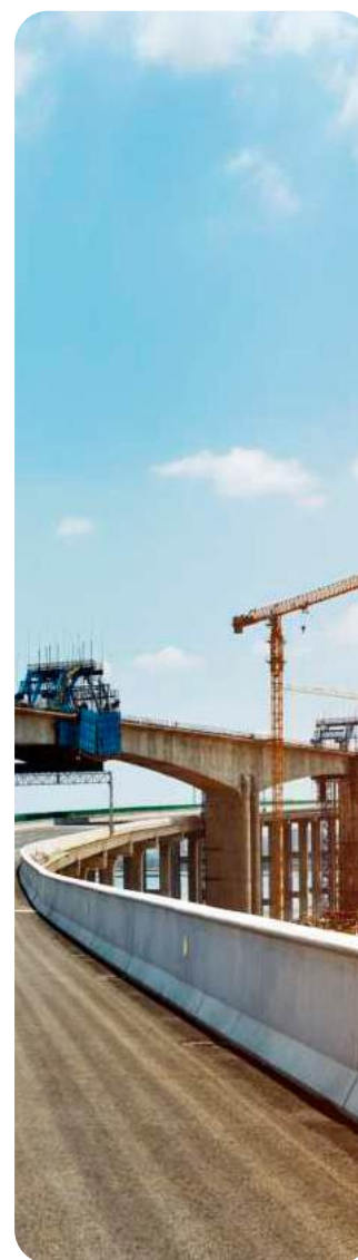
XÂY DỰNG ĐẦU TƯ HẠ TẦNG
