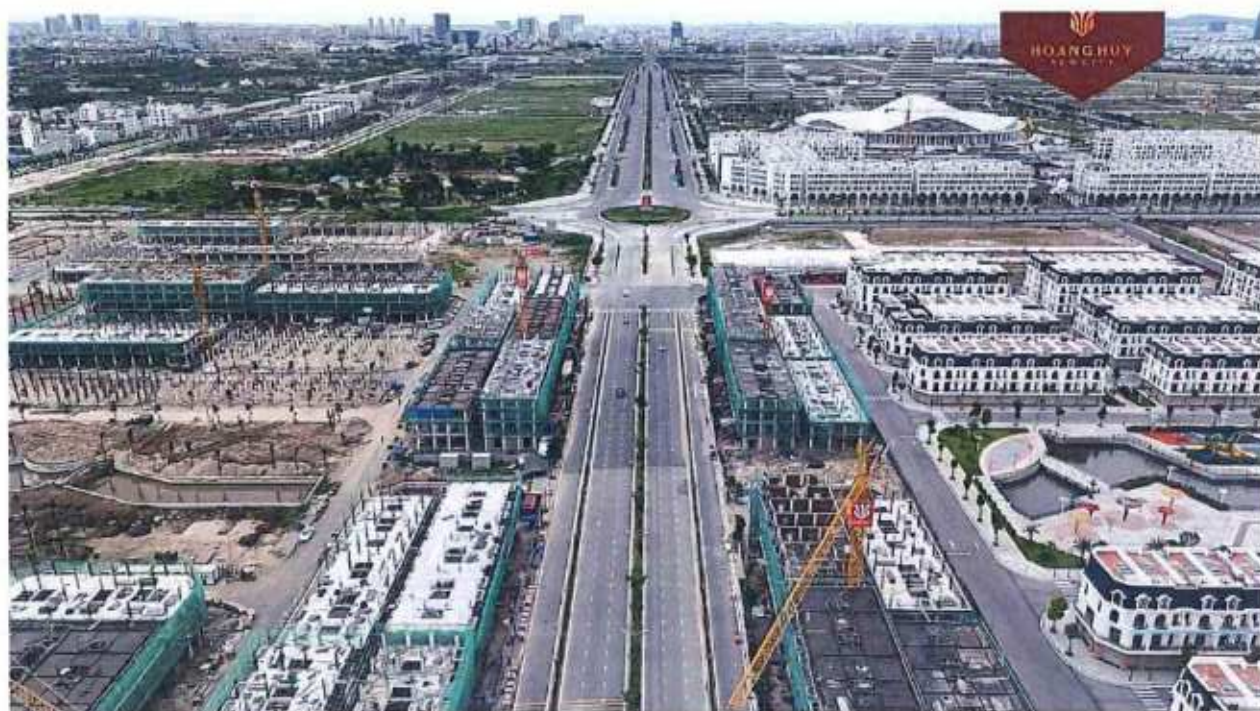
Hình ảnh thi công thực tế của dự án tại thời điểm tháng 09/2025
