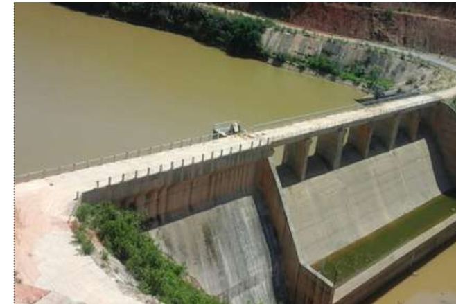
Nhà máy Thủy điện Đắk Mi 3 IDICO thi công nhà máy thủy điện Đắk Mi 3, công suất 63MW trong khoảng 3 năm từ 2014-2027
