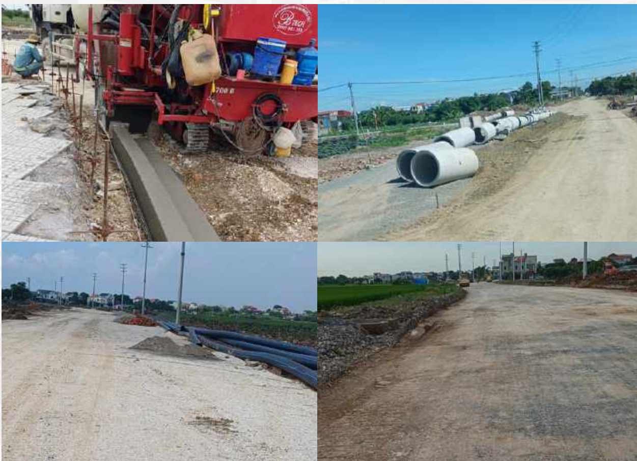
Hình ảnh thi công dự án
