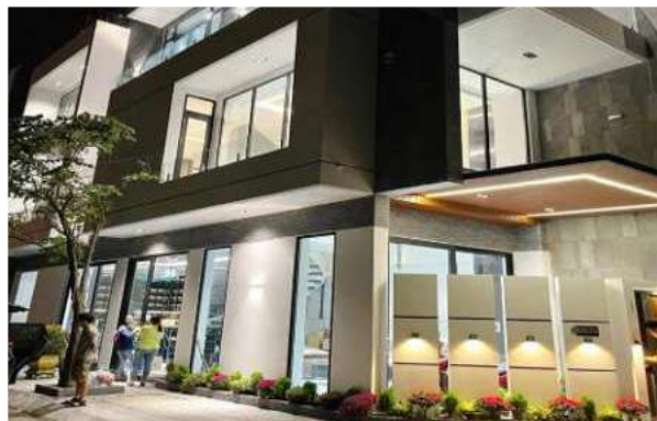
Công trình chiếu sáng Smart Home tại TP. Huế
