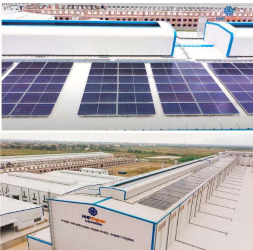
Hệ thống điện năng lượng mặt trời để tăng sử dụng nguồn năng lượng tái tạo
