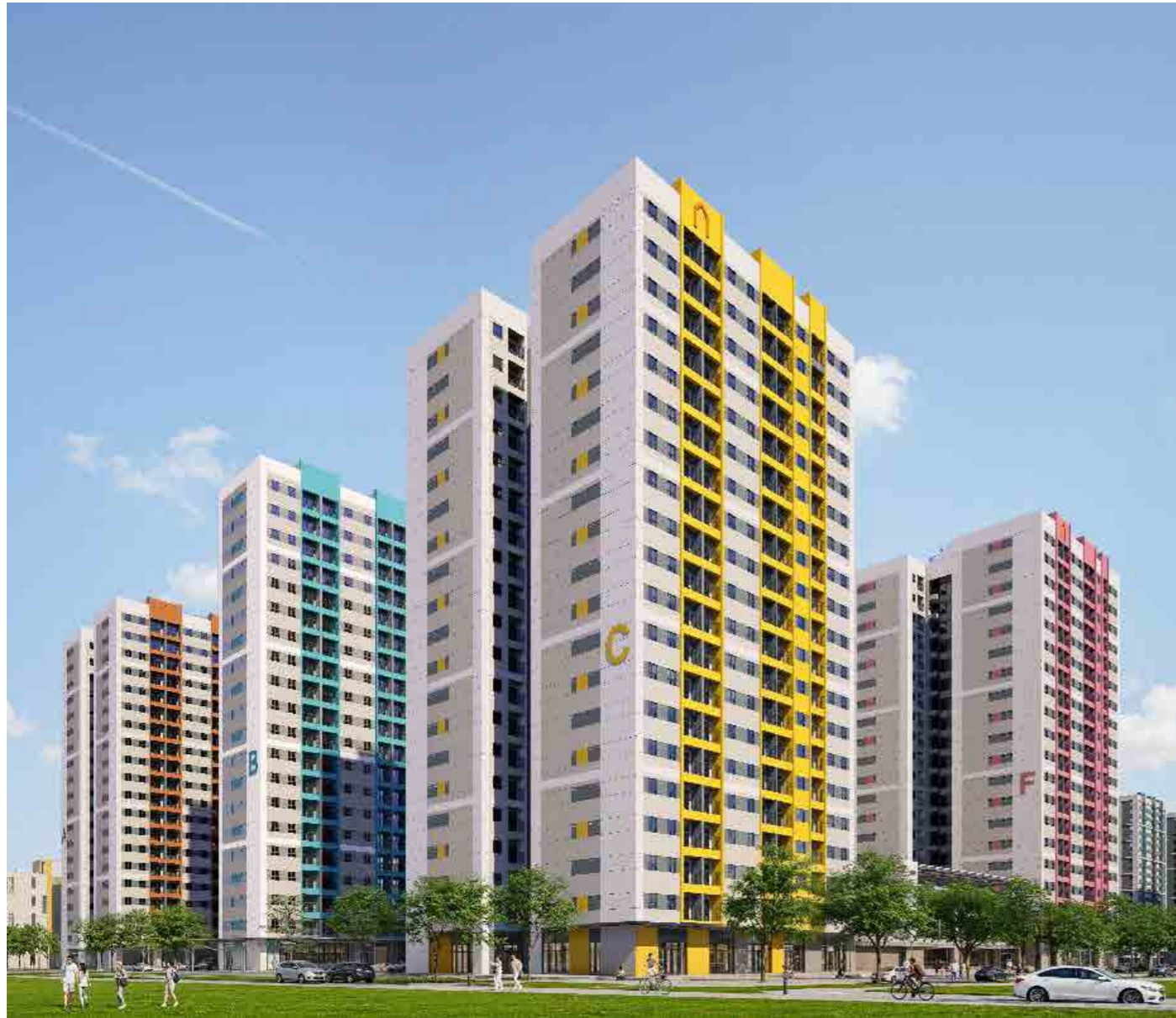
Khu nhà ở xã hội Định Hòa (Khu 5) đang thi công xây dựng
