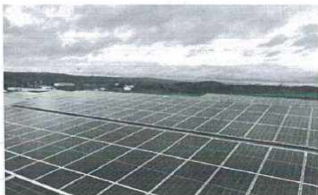
Dự án Điện áp mái tại Thôn Đa Hoa
