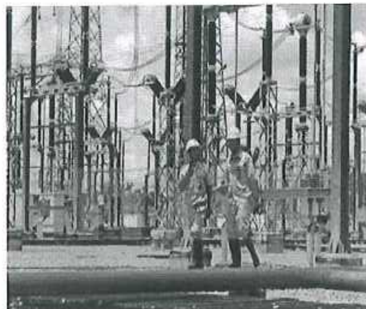
Dự án cấp điện lưới Quốc gia cho Đào Rều, thành phố Cẩm Phả, tỉnh Quảng Ninh
