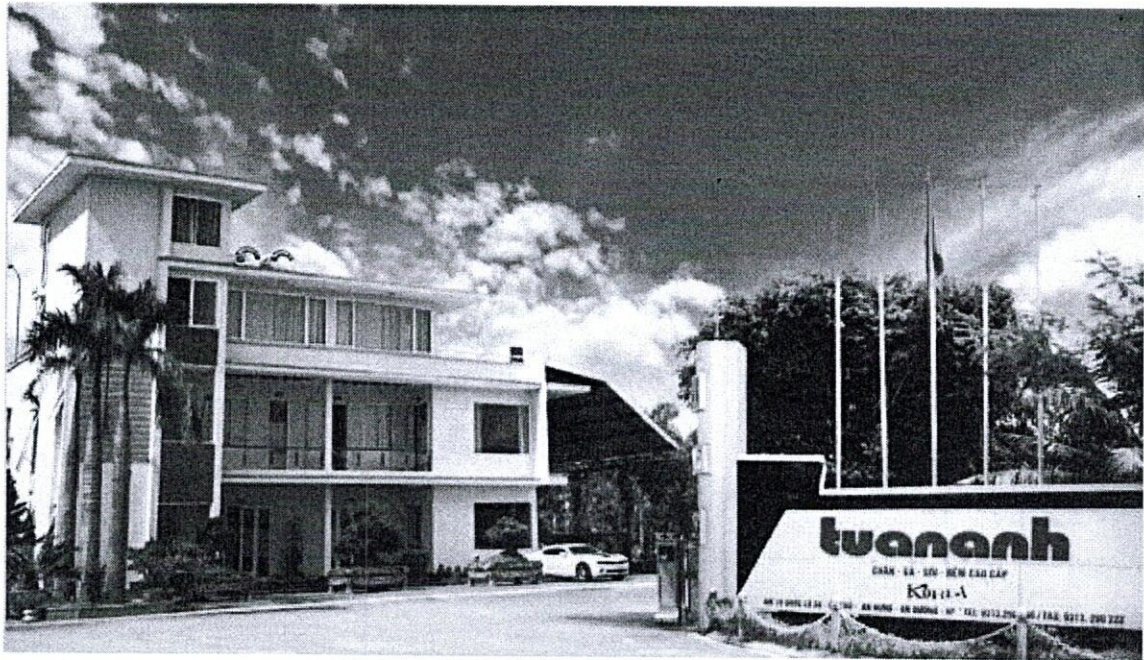
Nhà máy Công ty Cổ phần Đầu tư Sản xuất và Thương mại Tuấn Anh đặt tại địa chỉ Km13 Quốc lộ 5, Phường Hồng An, TP Hải Phòng
