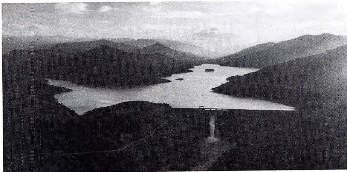
Ảnh 3. Đập chính của nhà máy thủy điện Hòa Na
