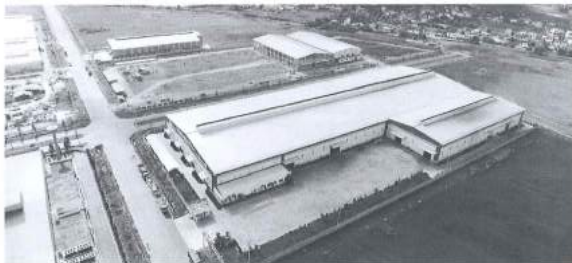
Hình 9. Nhà máy Ống Long An của Tôn Nam Kim
