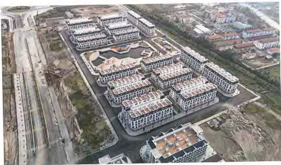
Toàn cảnh dự án đã hoàn thành nhìn từ trên cao
