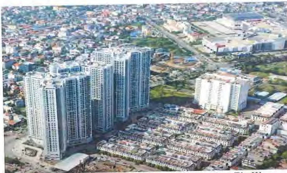
Hình ảnh bao quát dự án Hoang Huy Commerce - Tòa H1
