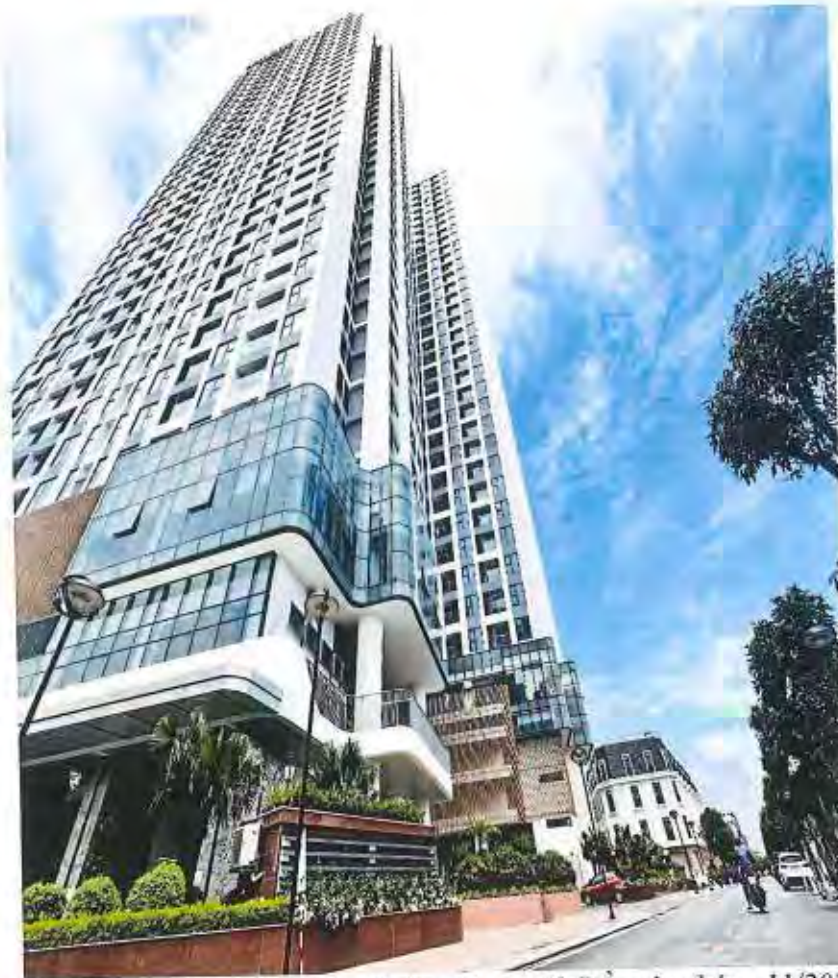
Hình ảnh mặt trước dự án Hoàng Huy – Sờ Dầu vào tháng 11/2024
