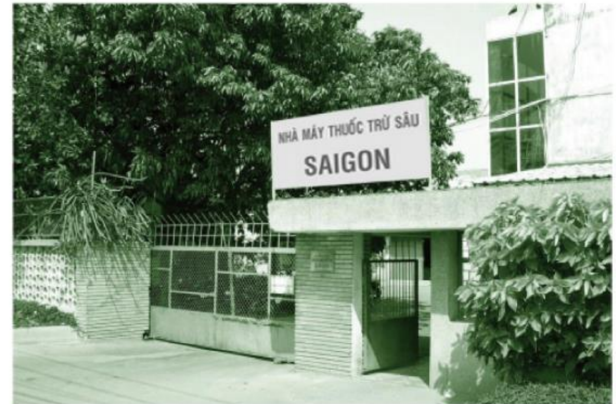
Trụ sở Nhà máy Thuốc trừ sâu Sài Gòn
