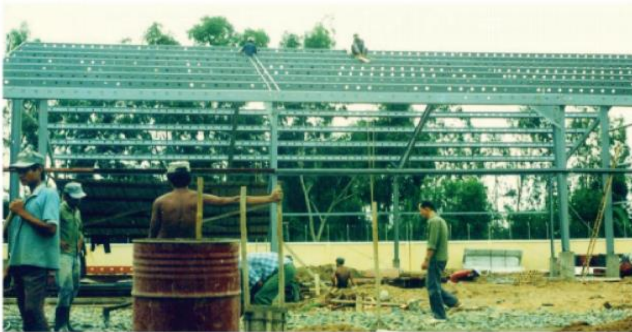
Khởi công xây dựng nhà máy
