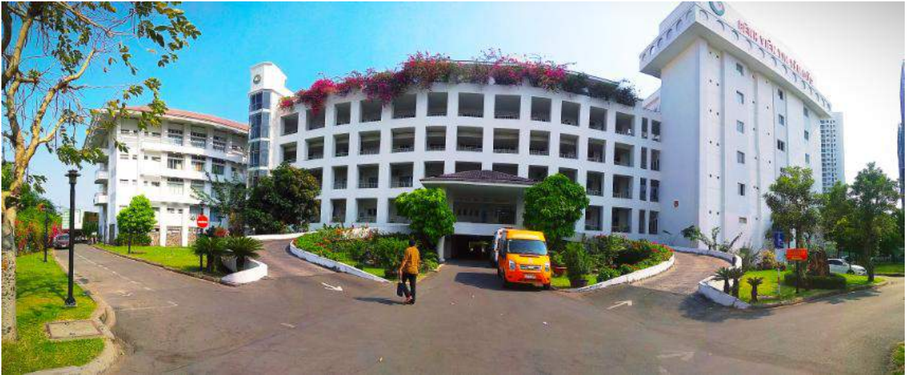
Đường vào cấp cứu TÂM ĐỨC
