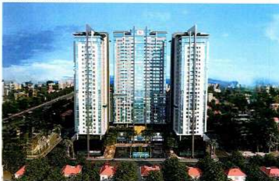
Hình ảnh hạng mục N01 thuộc dự án Golden Land Building
