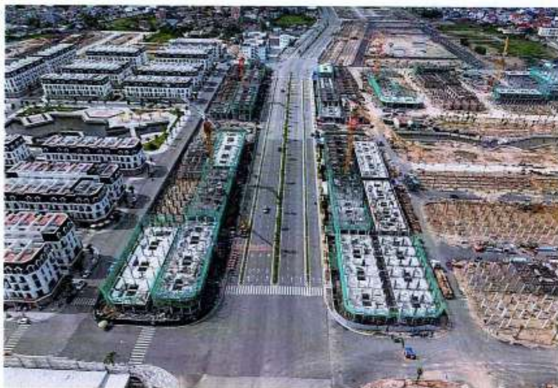
Cận cảnh hình ảnh thi công thực tế của dự án tại thời điểm tháng 08/2025
