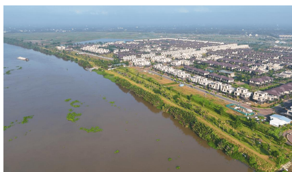
Hình 9. Dự án Waterpoint
