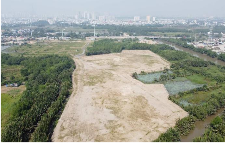
Hình 11: Dự án The Clarita – Đã bắt đầu xây dựng vào tháng 10/2023.
