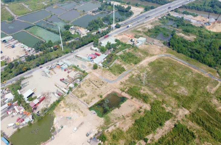
Hình 12: Dự án The Emeria – Đã hoàn thành quy trình đền bù và giải phóng mặt bằng, kỳ vọng bắt đầu xây dựng vào Q1/25.
