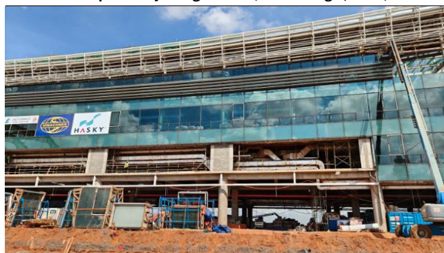
Ảnh 8. Tiến độ sân bay Long Thành (cuối tháng 5/2025)
